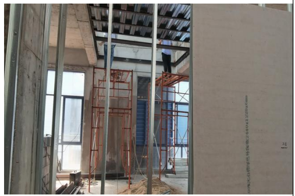
实验室内部现状
