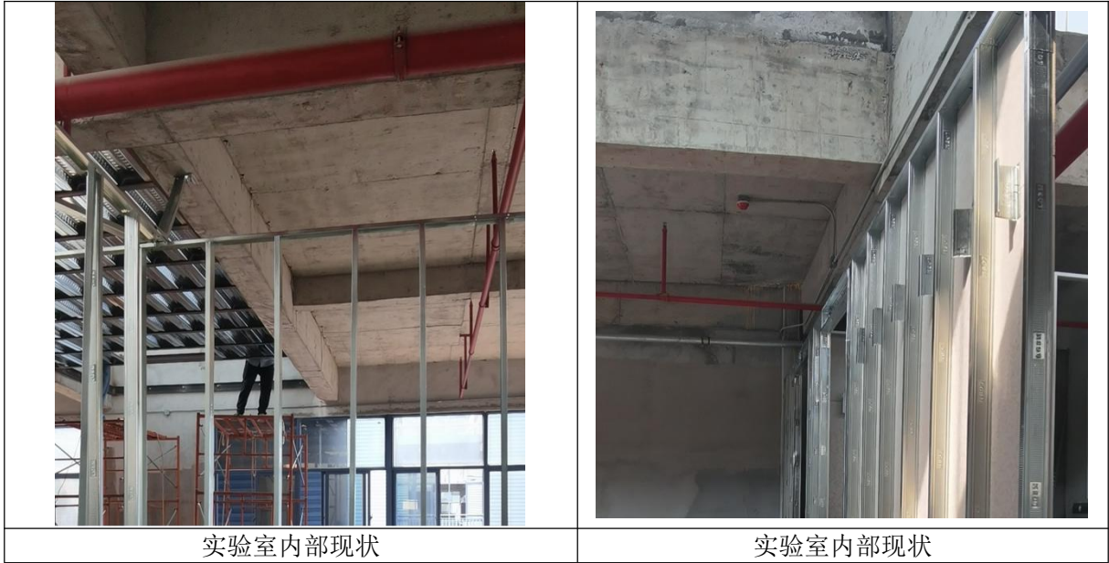
附图 3 建设项目四至实景图及实验室内部现状图
