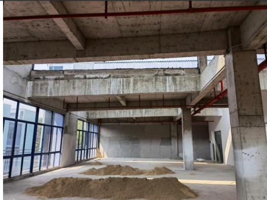
实验室内部现状
