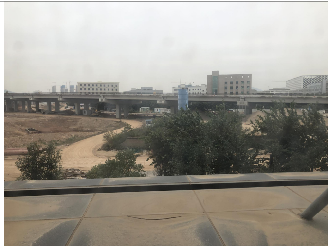
西面-金琴快线延长线工地
