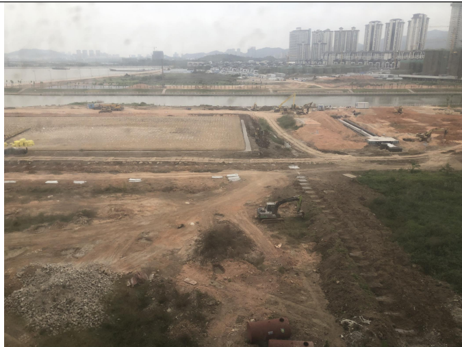
南面-在建工地
