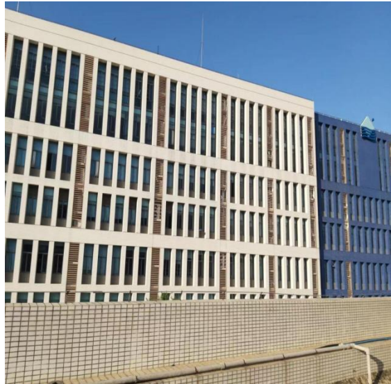
项目北面：北斗产业园 A 栋
